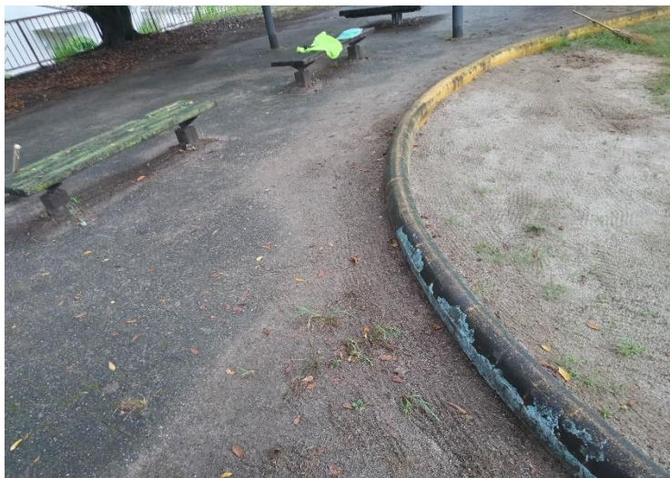
清掃後、綺麗になった「砂遊び場」と「ベンチ周り」
