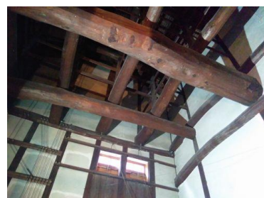
岡屋家の天井
