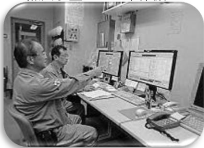
遠隔制御監視室
