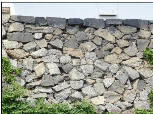
城郭の石垣の種類は、大きく分けると石の加工度合い(「野面積」<sup>のづらづみ</sup>「打込接」<sup>うちこみはぎ</sup>「切込接」<sup>きりこみはぎ</sup>)の三種類と石の積み方(「乱積」<sup>らんづみ</sup>「布積」<sup>ぬのづみ</sup>)の二種類の組み合わせから六つに大別されます。左の写真の「加工度合い」と「積み方」を書きましょう。
