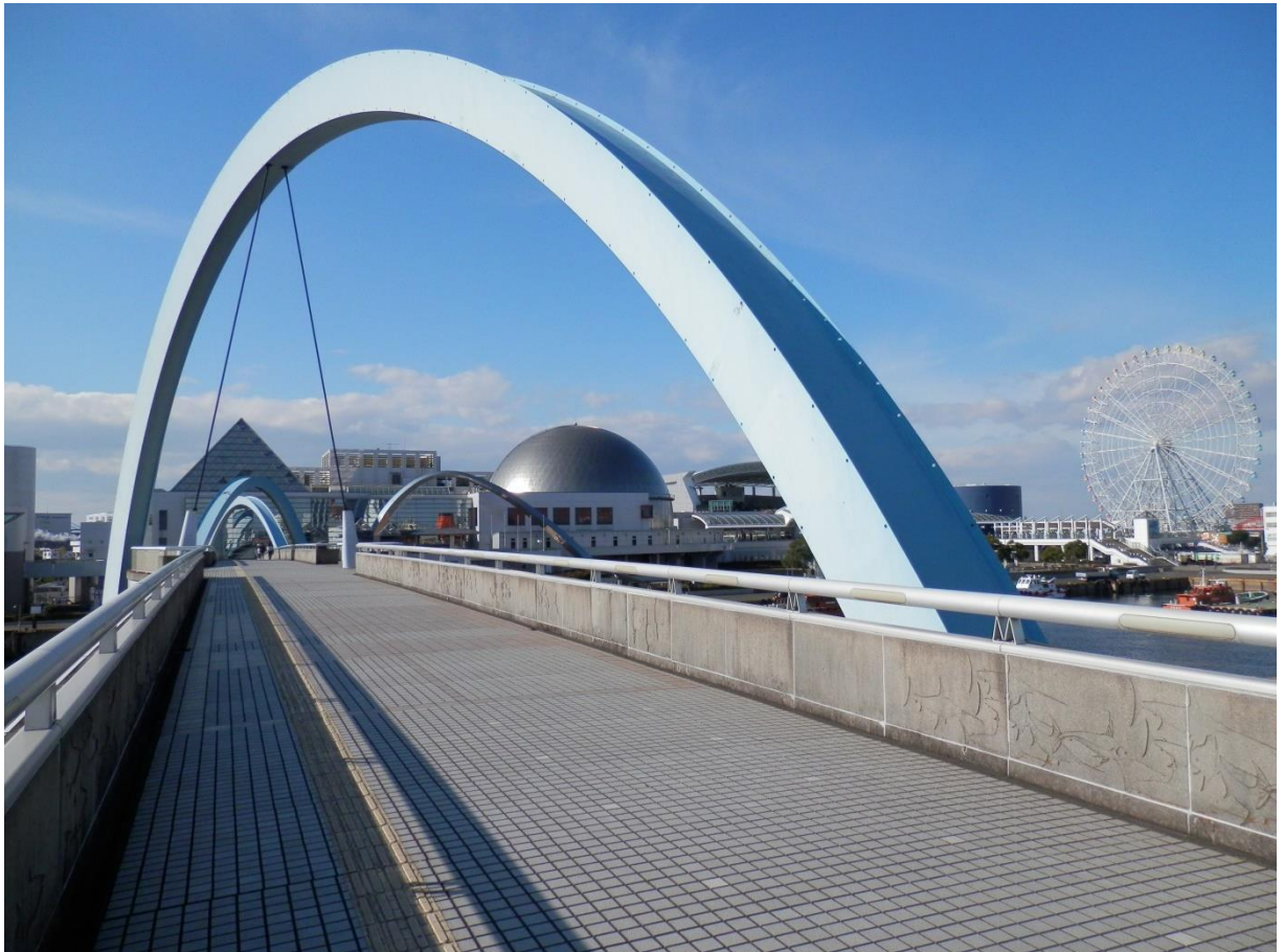
名古屋港ガーデンふ頭《名古屋港水族館》
