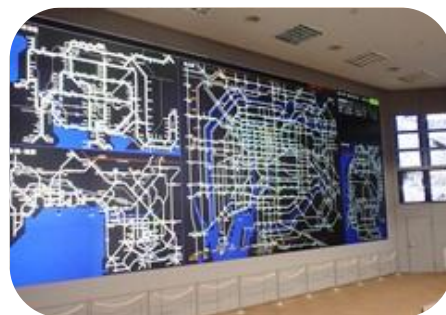
交通管制センター
