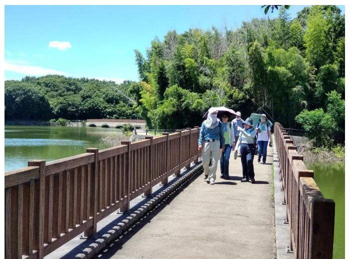
勅使池は土堰堤の耐震補強工事が終わり、満水状態でした。水面を渡る西風は幾らか涼しい！
