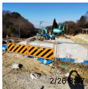
農業灌漑用の梶貸池整備工事中、随分長期の工事だが今年中には完了か？
