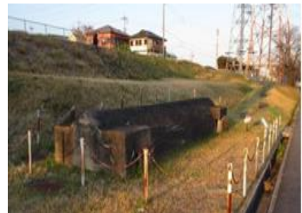
日進変電所防空壕
