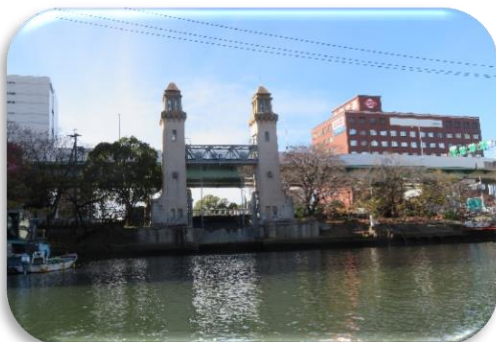
◇堀川と中川運河を結ぶ松重閘門(1932~1968)
